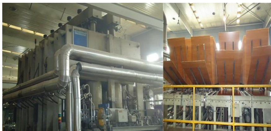
压板热压工艺线
